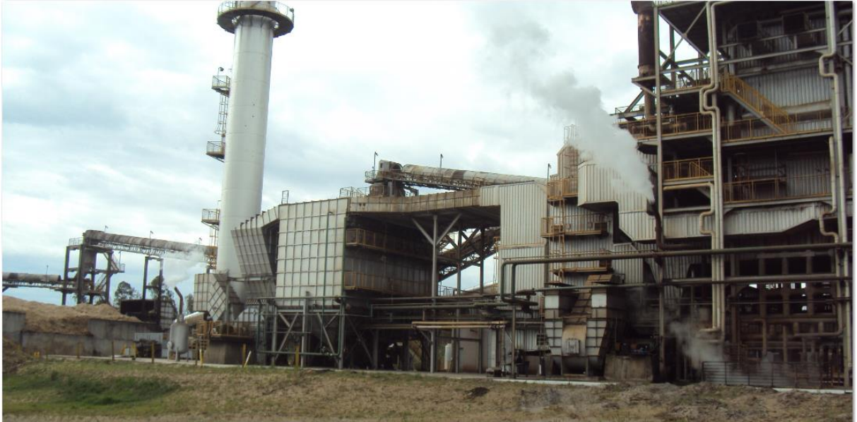
Figura 9 - Vista lateral da caldeira em estudo
