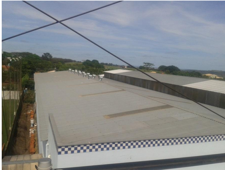
Figura 24 – Exaustores e Telhas transparentes vista superior
