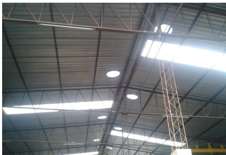
Figura 23 – Exaustores e Telhas transparentes
