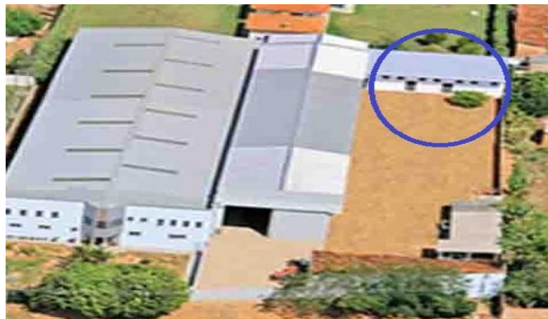
Figura 14 –Setor de elétrica
