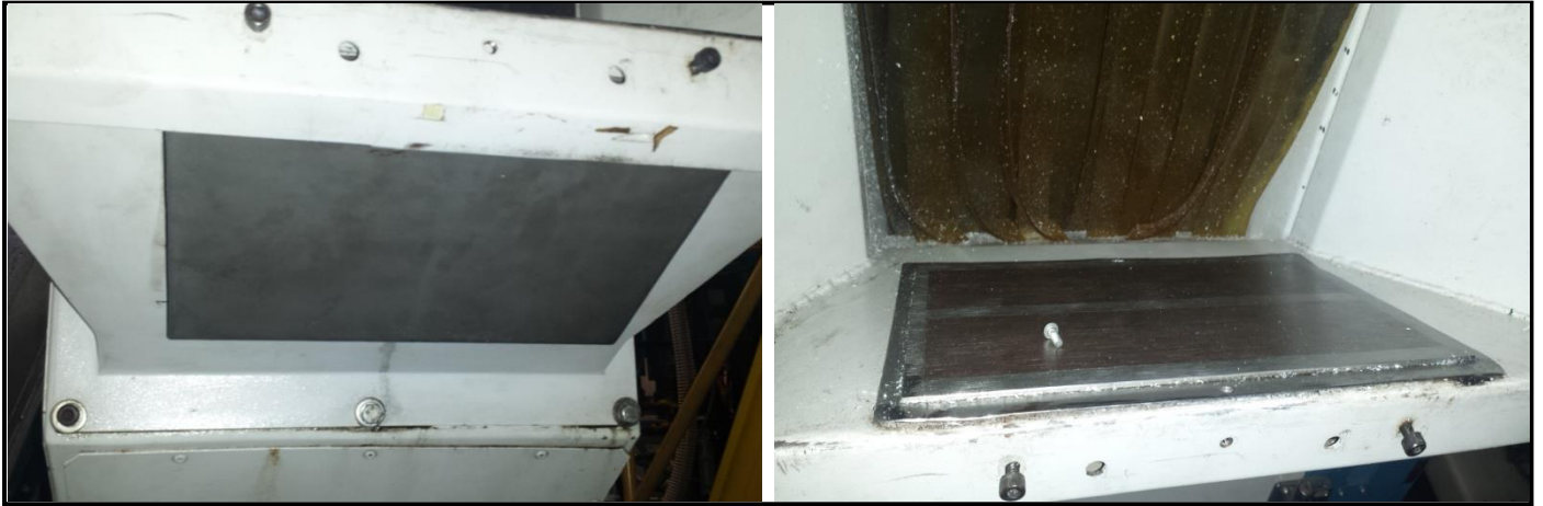
Figura 29 – Placas de Imã Instaladas
