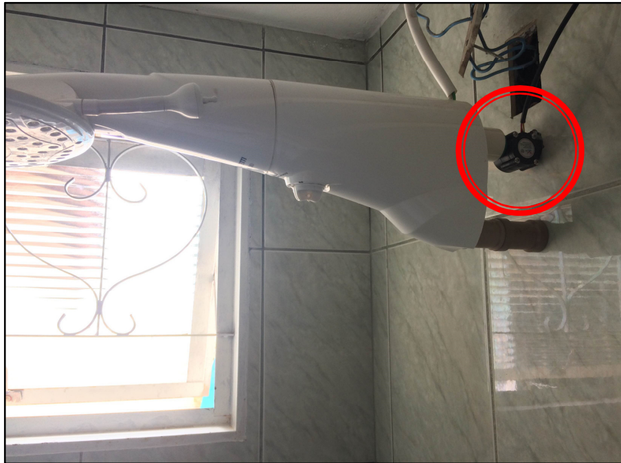
Figura 37 - Módulo sensor instalado no chuveiro
