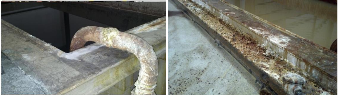
Figura 14 - Tubos e superfícies sujas e oxidadas.
