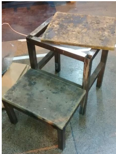
Figura 12 - Escada com assoalho solto.
