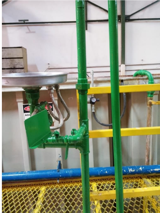
Figura 29 - Tubos e estruturas pintados.
