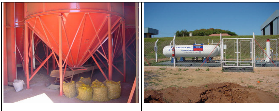
Figura 28: Secador – Visão externa (cap. 20.000 Kg.) e ao lado, o combustível.
