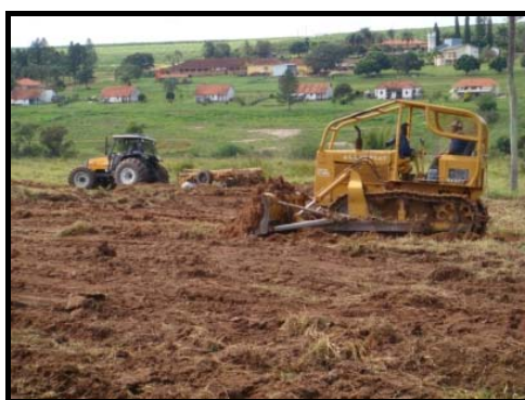
Máquina drenando o terreno
