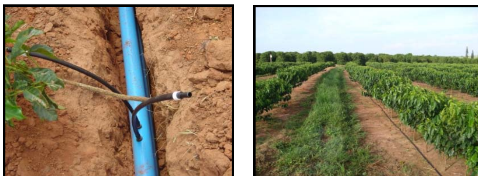
Processo para instalação da Irrigação
