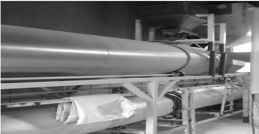
Figura 3 – Adaptação no posicionamento dos fornos.
