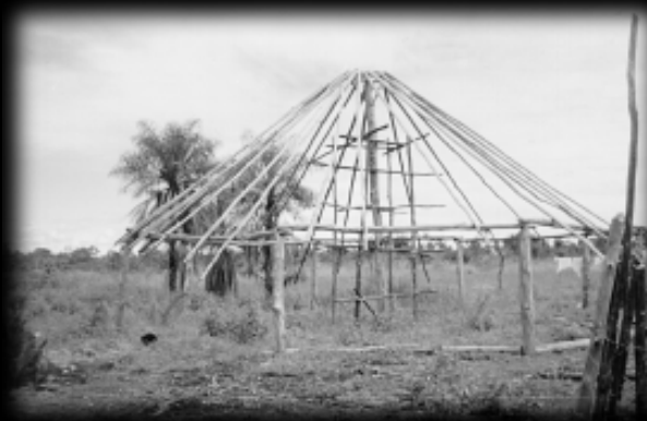
Casa xavante típica. A foto mostra a estrutura de madeira que será coberta com folhas de buruti
