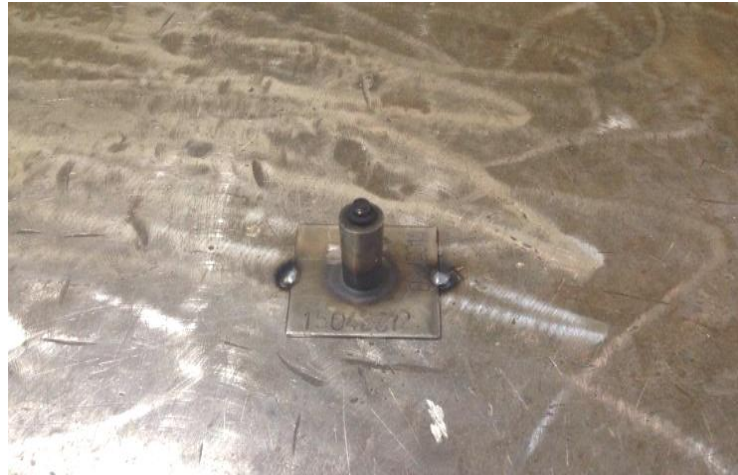
Figura 4 – Método de fixação dos gabaritos com solda.
