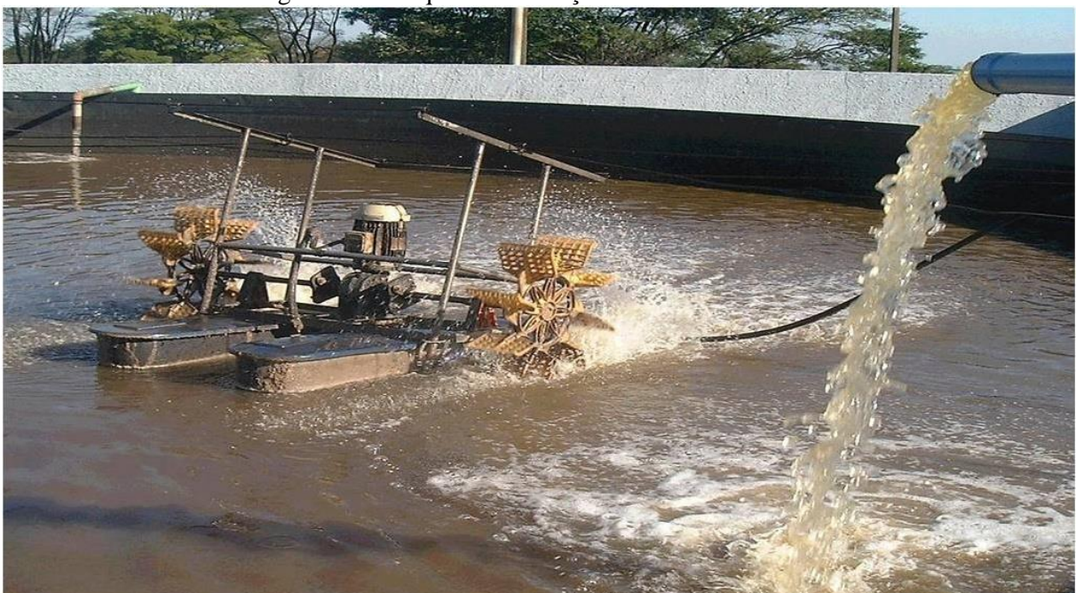
Figura 16 - Tanque de Contenção de Efluente Tratado
