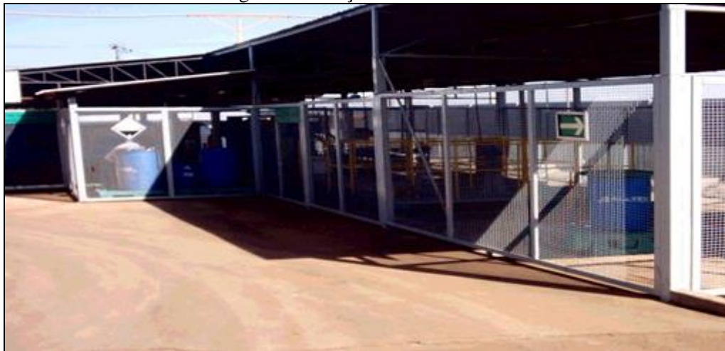
Figura 7 - Estação de tratamento
