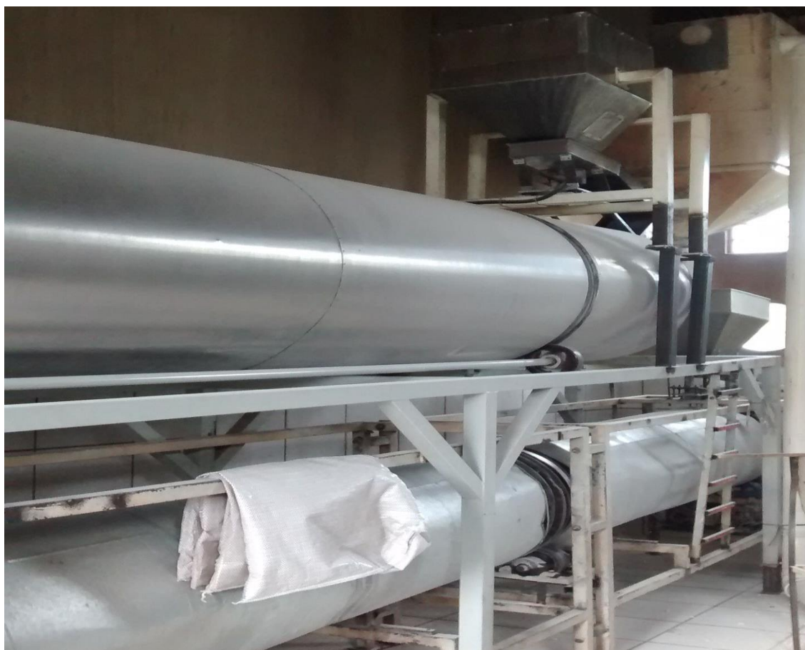
Figura 9 – Adaptação no posicionamento dos fornos.
