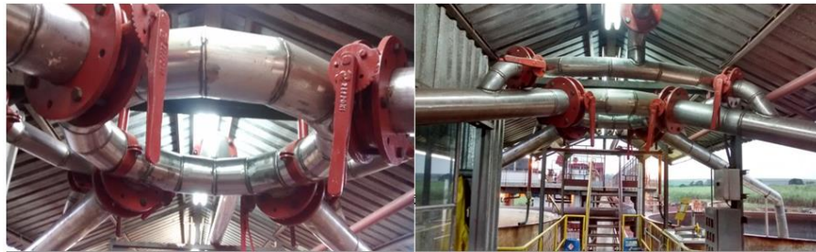
Figura 8 - Anel de distribuição de mosto nas dornas de fermentação
